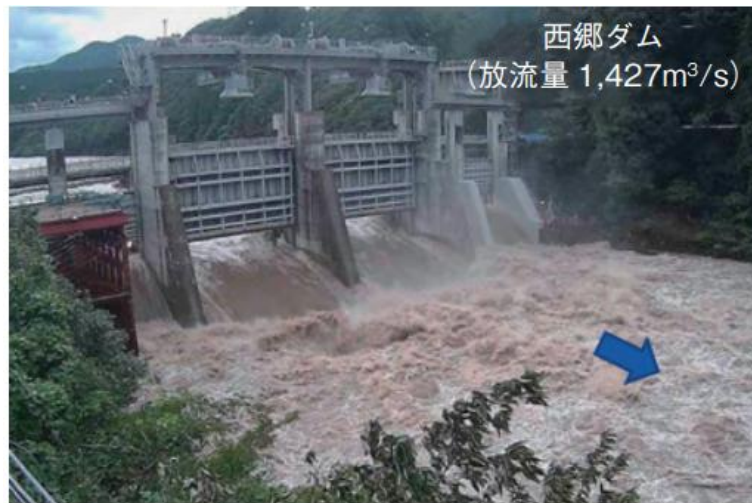
図 4-36 山須原ダム・西郷ダムの改造状況
